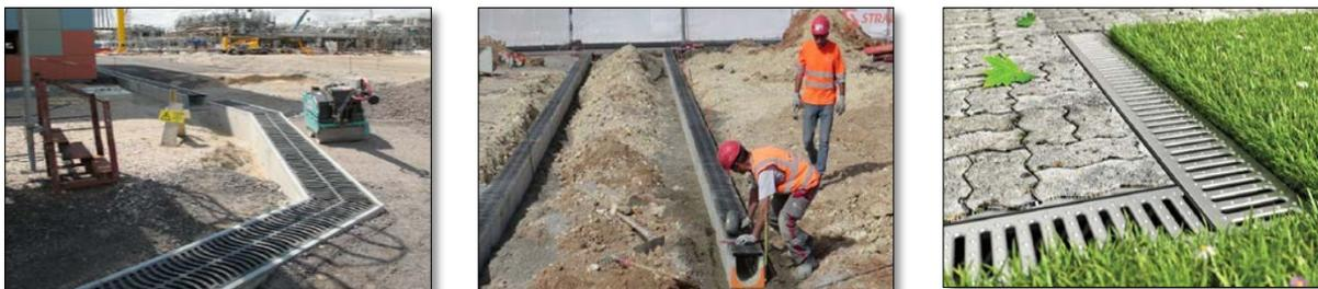
Figure V 2 : Les caniveaux à grilles
