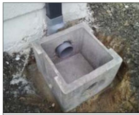
Figure V 10 : Regard en béton
