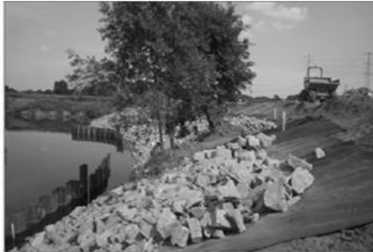
Figure III.10. Revêtement en enrochement en construction sur un géotextile
