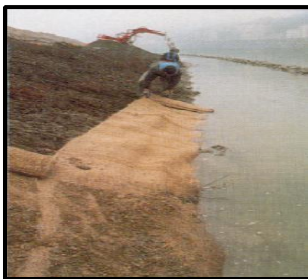
Figure III.4. Mise en place de couches de branches et recouvrement avec un géotextile putrescible
