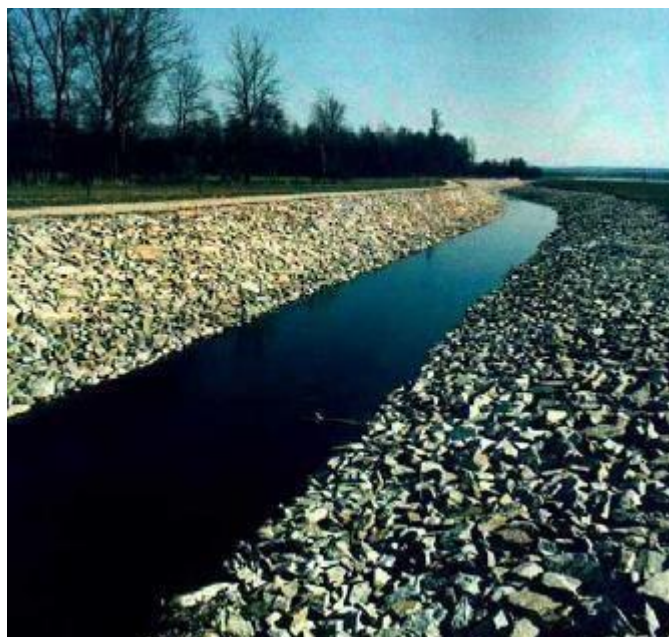
Figure.III.16.Enrochement pour les rivières en plaine
