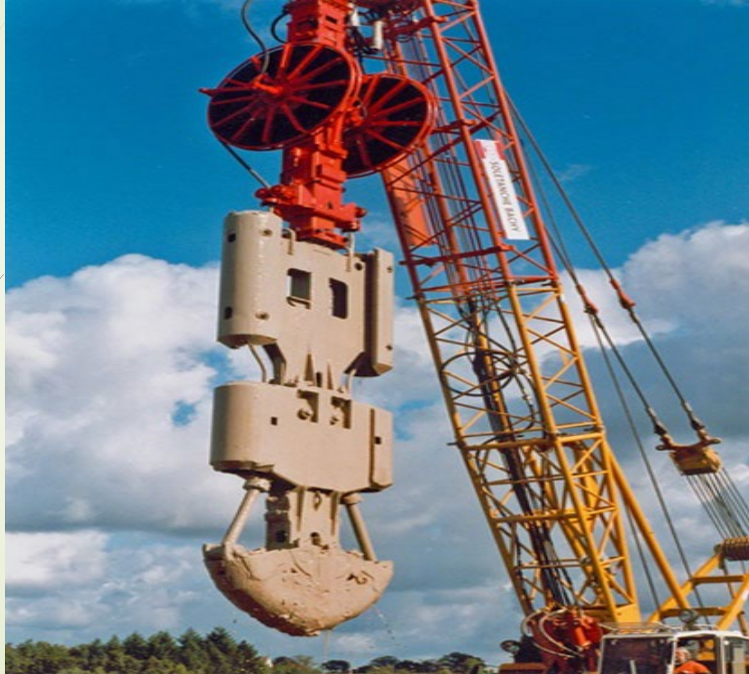
Excavatrice de parois moulées
