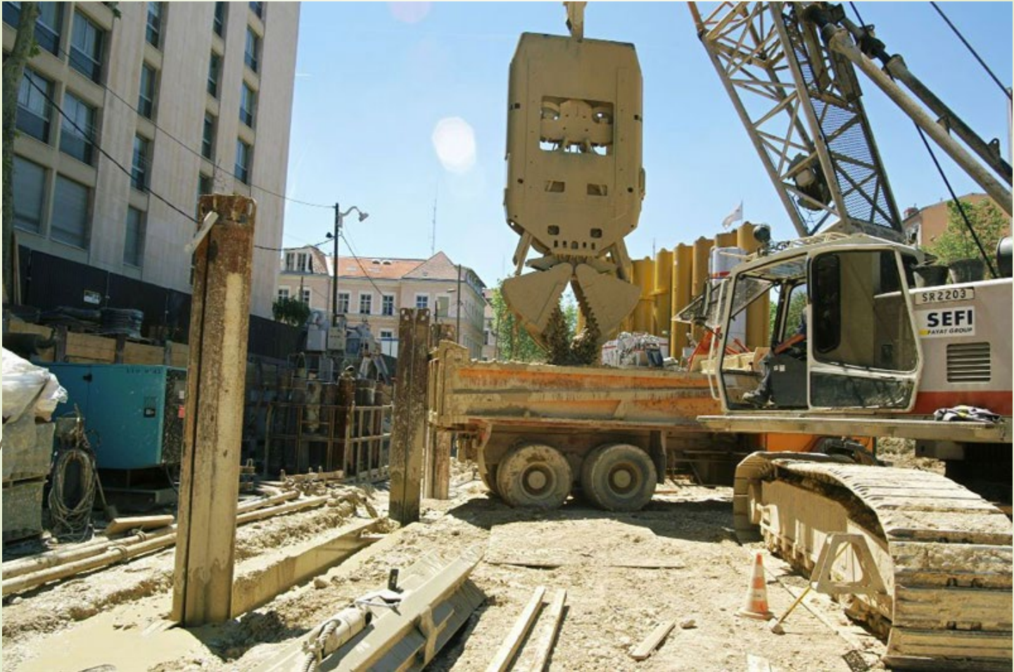
Excavatrice de parois moulées
